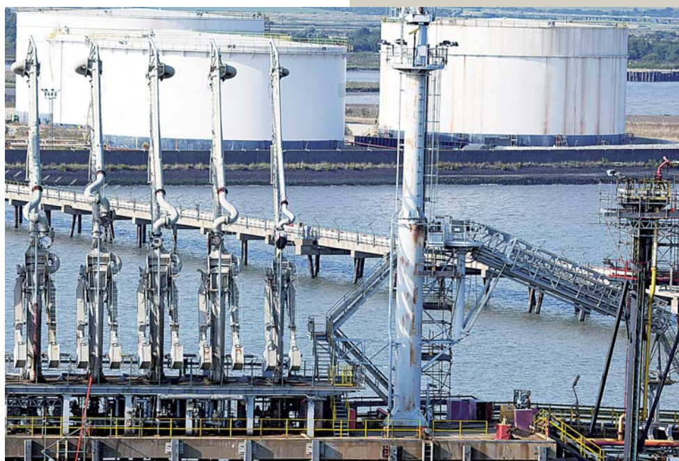
Рис. 1. Резервуарный парк с терминалом
