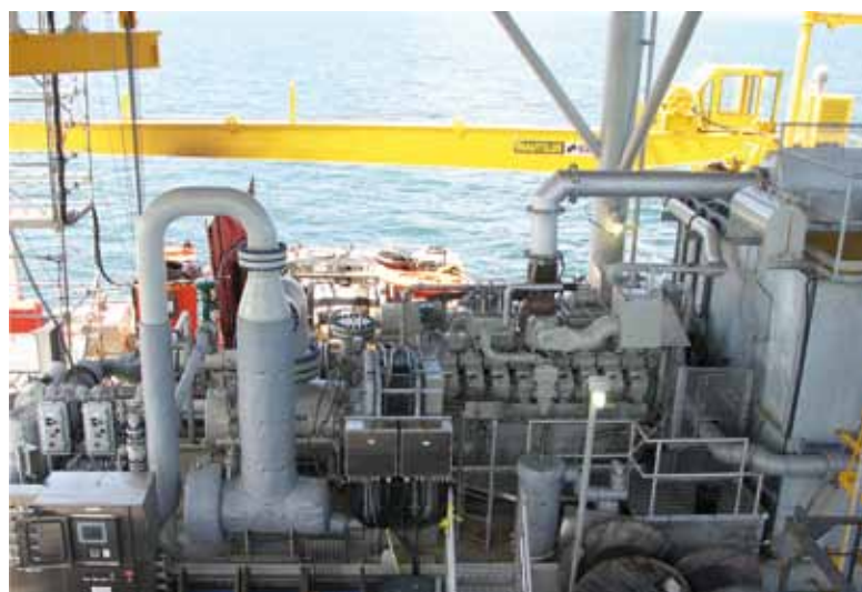
Abb. 2: Multiphasen-Förderpumpe auf einer Bohr-Plattform
