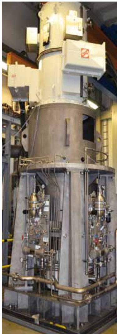
Abb. 4: Vertikale, zweispindeliger Schraubenspindelpumpe als Rohölexportpumpe für ein FPSO
