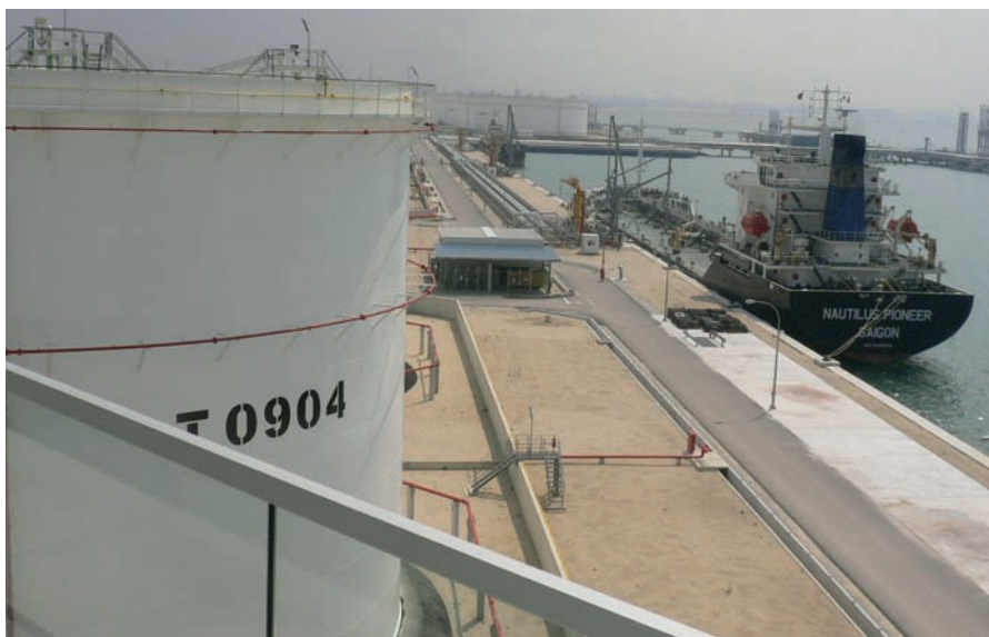
Загрузочный терминал и нефтехранилище в Сингапуре
