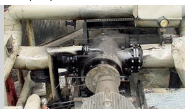
Pompa przetłaczająca Leistritz L4MG
