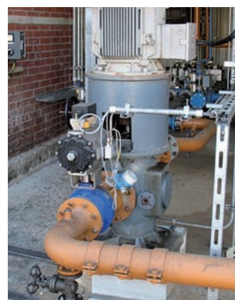
Насос для перекачки полиуретана Leistritz L3MG
