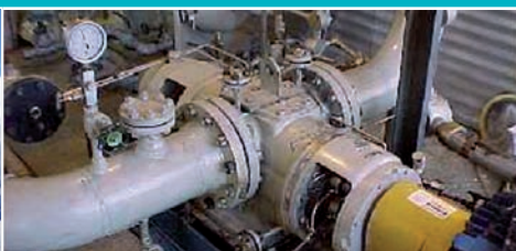
Мультифазный насос Leistritz на канадском нефтяном месторождении Q = 100 \text{ м}^3/\text{ч} \cdot \Delta p = 6,0 \text{ бар} \cdot GVF = 94 \%
