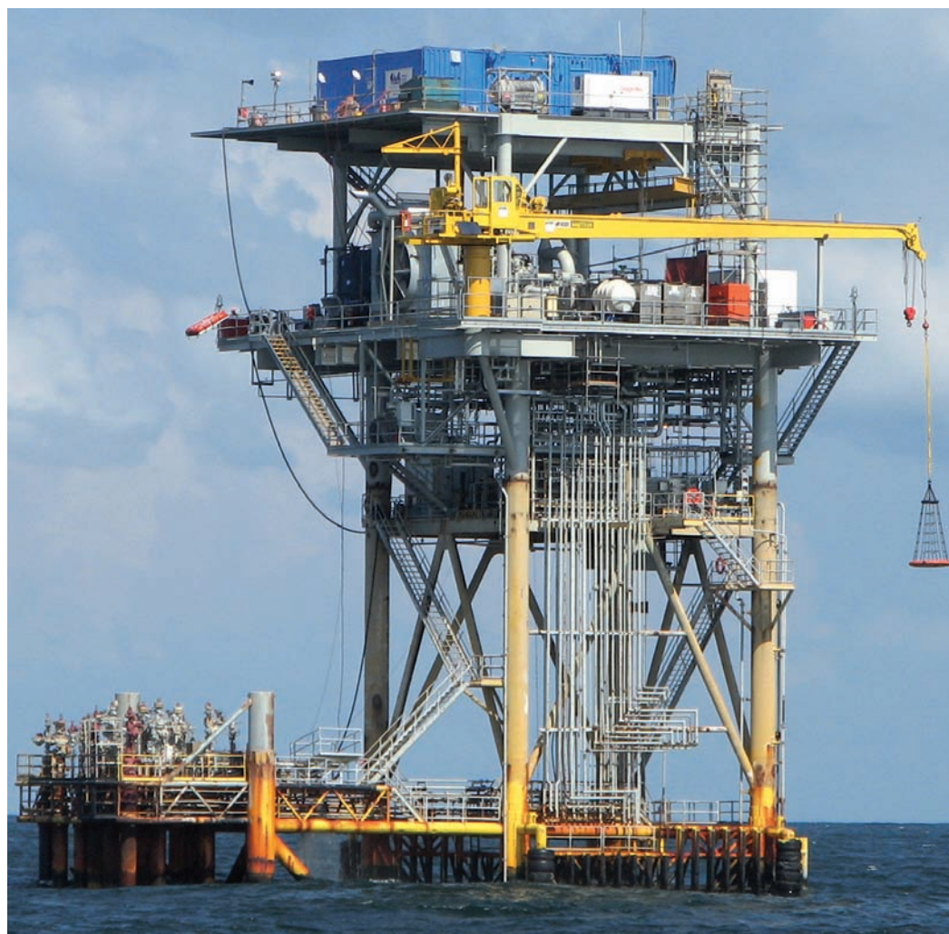
Морская платформа с мультифазным насосом Leistritz на опорной раме в Мексиканском заливе
