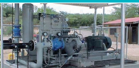
Мультифазный насос Leistritz в тропическом лесу Южной Америки Q = 304 \text{ м}^3/\text{ч} \cdot \Delta p = 15 \text{ бар} \cdot GVF = 59 \%
