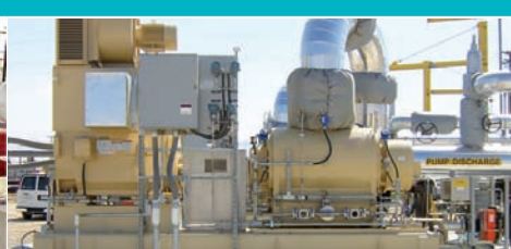
Мультифазный насос Leistritz с изоляцией на калифорнийском нефтяном месторождении Q = 966 \text{ м}^3/\text{ч} \cdot \Delta p = 14,8 \text{ бар} \cdot GVF = 97 \%
