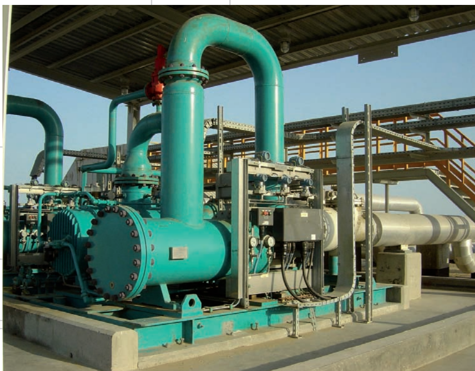
Мультифазные насосы Leistritz на нефтяном месторождении в Каспийском море
