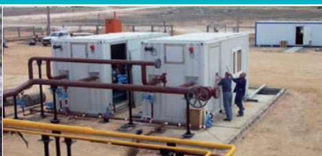
Мультифазный насос Leistritz в контейнерном исполнении в районе вечной мерзлоты в Казахстане Q = 175 \text{ м}^3/\text{ч} \cdot \Delta p = 38 \text{ бар} \cdot GVF = 86,6 \%
