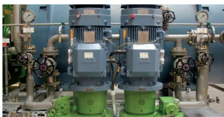
2 Вспомогательный насос L3MF для смазочного масла
