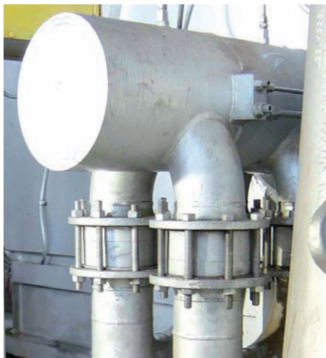
3 Насос L3MG для смазочного масла понижающего редуктора
