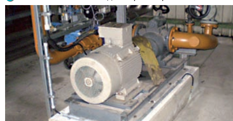
5 Насос L4NG для мойки резервуаров
