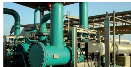
1 Многофазный подкачивающий насос L4МК
