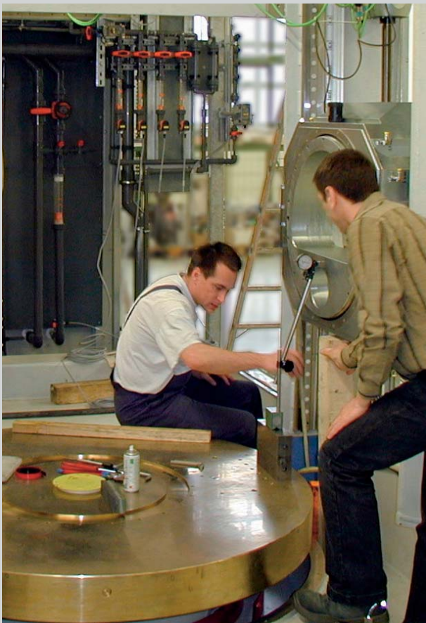
电化加工机床的安装
